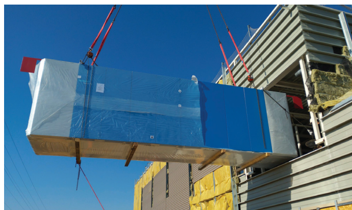
Manutention d'un tunnel de 6,5 t.
